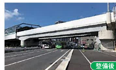
平成31年3月 鉄道高架化により国道踏切を除去 街路事業により道路を拡幅(4車線化)
