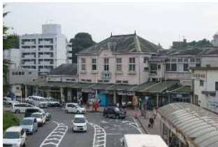
▲解体前の駅舎
