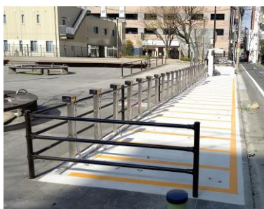
＜堺町地区の駐輪施設＞
