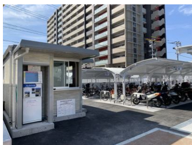
＜八幡駅前自転車駐車場＞
