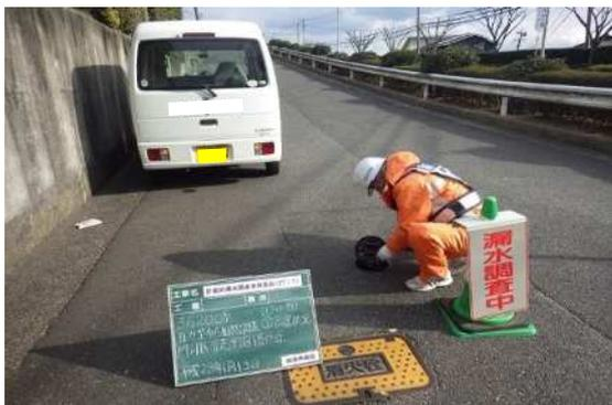
高感度音圧センサー、設置・回収
