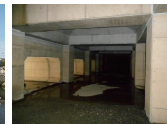
天籟寺川地下調節池（内部）
