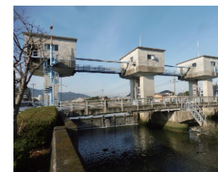
貫川防潮水門
