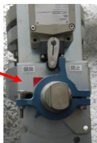
閉止弁（常時開、点検時閉）
