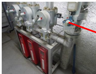
閉止弁（常時開、点検時閉）
