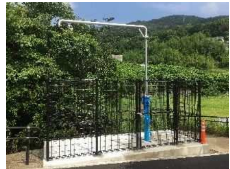
応急給水施設(給水塔)
