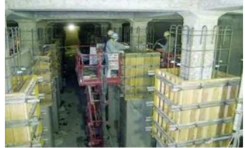
配水池の耐震化工事 (内面からの壁・柱等の補強) (厚生労働省HPより引用)
