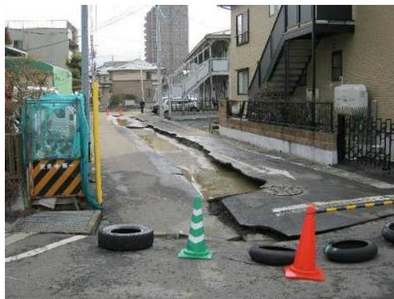
平成 23 年東日本大地震 被災状況
