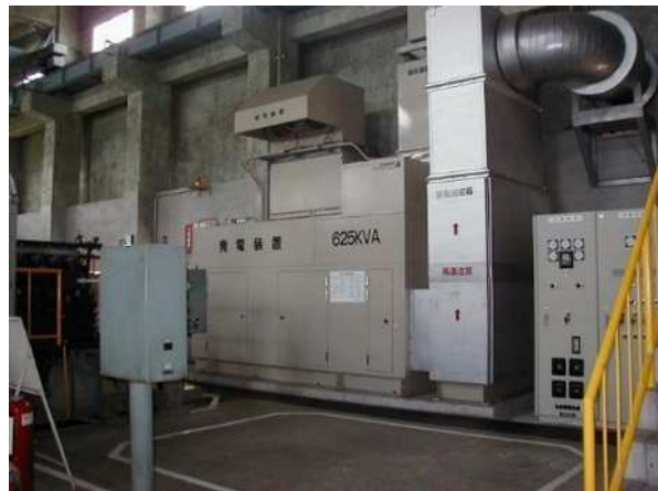
非常用発電設備(浅野町ポンプ場)
