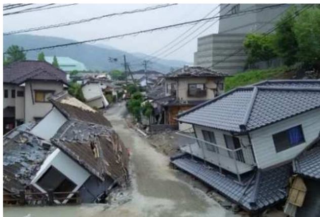
平成 28 年熊本地震 被災状況
