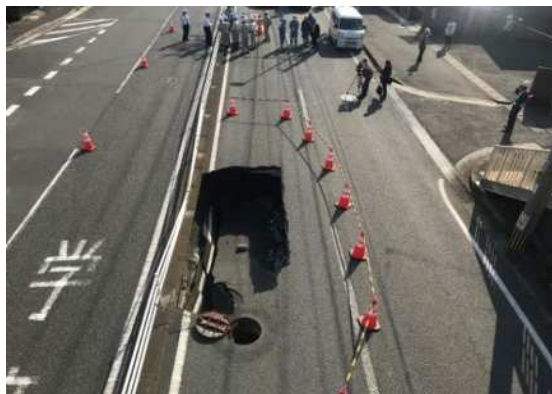
下水道管渠破損による道路陥没
