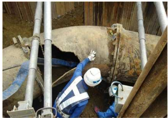
破損した水道管
