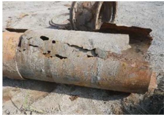
硫化水素により腐食した圧送管
