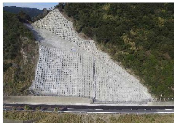
▲ 道路のり面の強化（対策イメージ）
