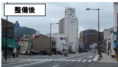
▲道路の無電柱化
