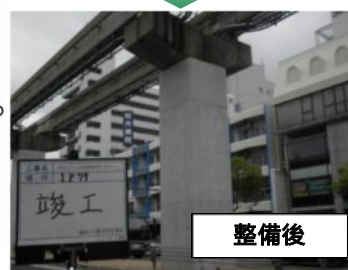
▲橋梁、モノレールの耐震対策（RC支柱の耐震補強）
