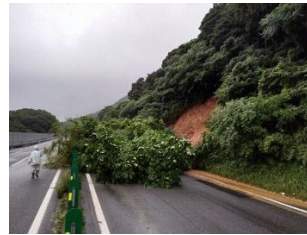
▲ H30.7豪雨災害 (北九州都市高速道路)
