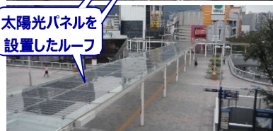
太陽光パネルの設置（JR黒崎駅ペDESTリアンデッキのルーフ）
