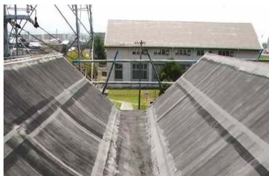
ポンプ棟屋上防水前
