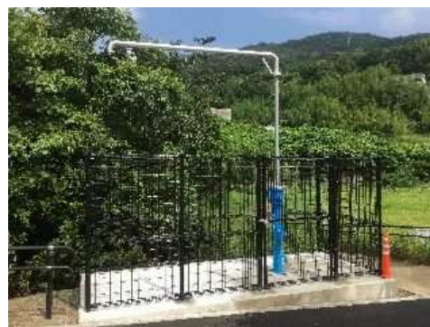
応急給水施設(給水塔)
