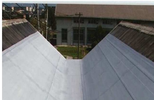
ポンプ棟屋上防水後
