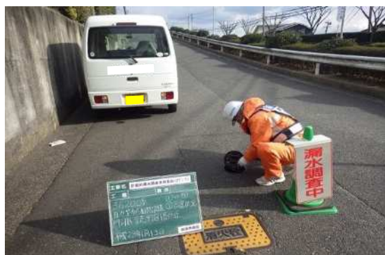
高感度音圧センサー、設置・回収
