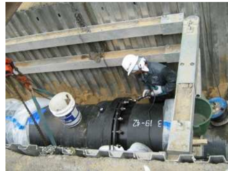
耐震管布設状況
