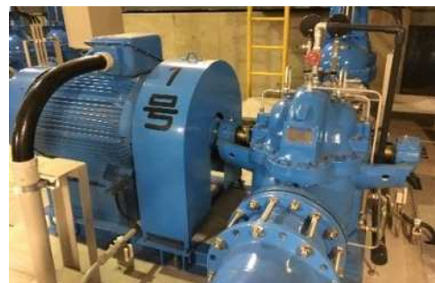
ポンプ設備更新(藤ノ木系送水ポンプ)
