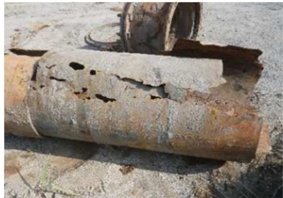
硫化水素により腐食した圧送管
