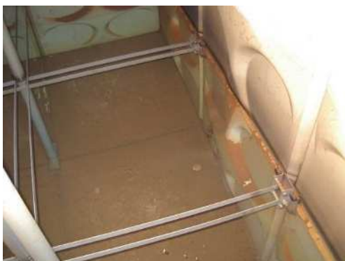
管理が不十分な小規模貯水槽(民間施設)
