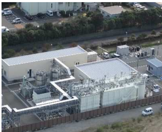
ウォータープラザ北九州外観
