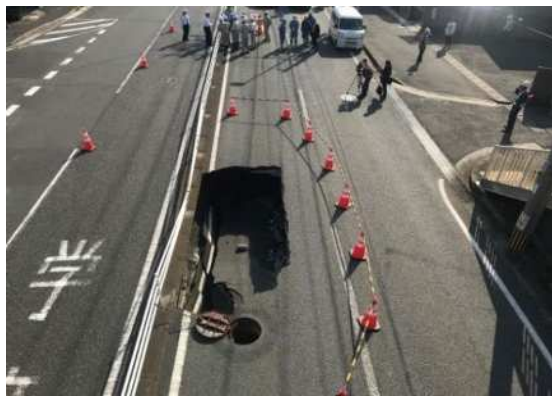
下水道管渠破損による道路陥没
