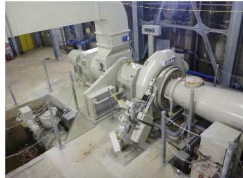
油木発電所(780kW)
