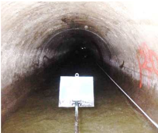
耐震化前の下水道管渠
