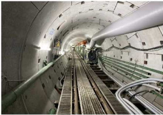
整備中の昭和町雨水貯留管
