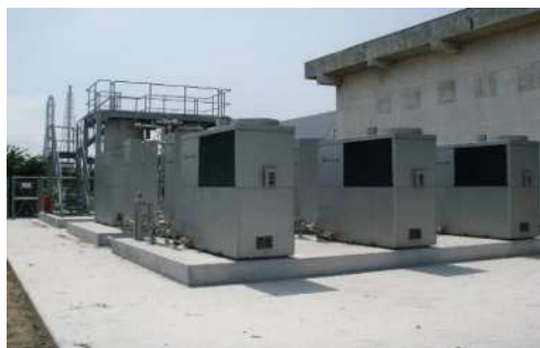
バイオガス発電*(日明浄化センター)
