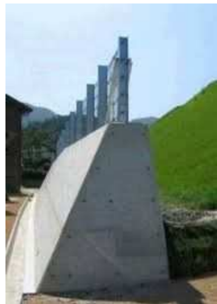
土砂災害対策の事例
