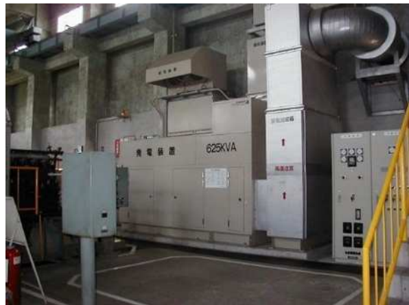
非常用発電設備(浅野町ポンプ場)
