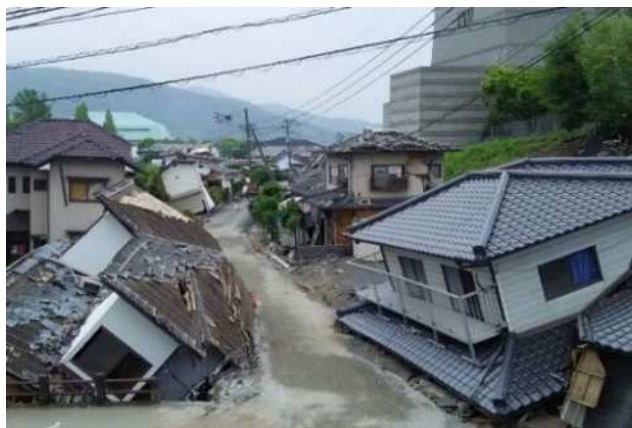
平成 28 年熊本地震 被災状況
