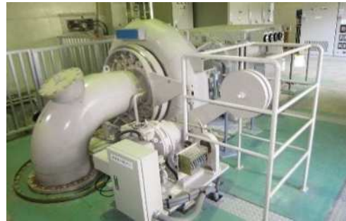
水力発電(ます漕発電所)
