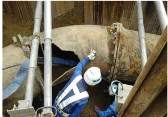
破損した水道管
