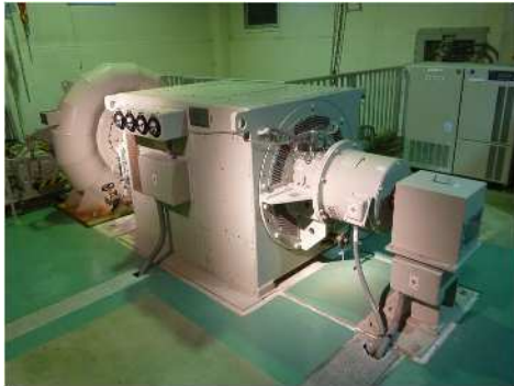
ます湊発電所(520kW)
