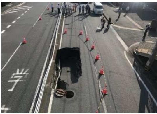
下水道管渠破損による道路陥没
