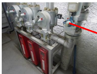
閉止弁（常時開、点検時閉）
