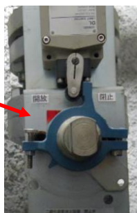
閉止弁（常時開、点検時閉）
