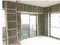
外壁の断熱改修
