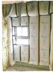
浴室外壁に断熱材を設置した例
