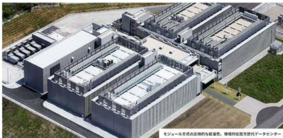
北九州データセンター
