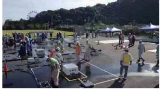
合同防災訓練(応急復旧)
