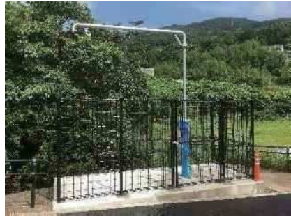
応急給水施設(給水塔)
