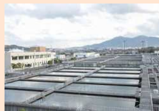
本城浄水場 沈殿池
