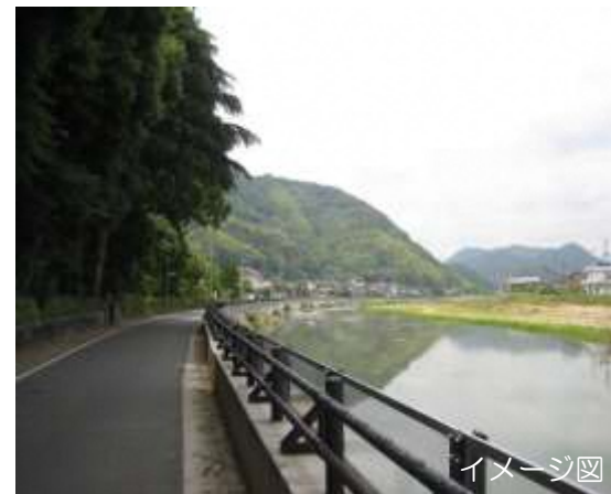
【護岸工事②（整備後）】
