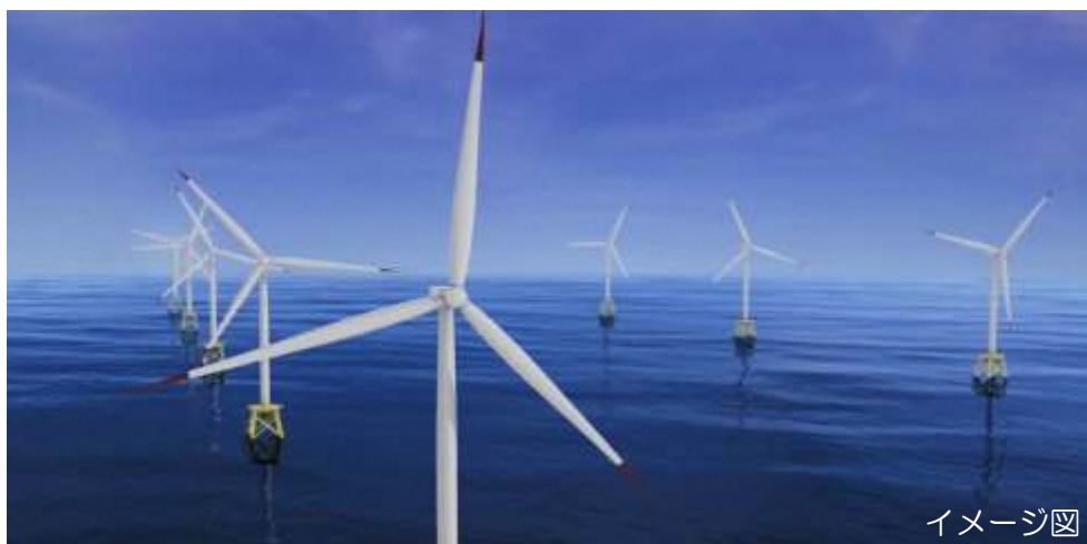
洋上風力発電関連事業
