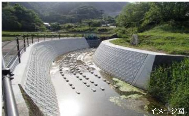
河川整備 【護岸工事①】
