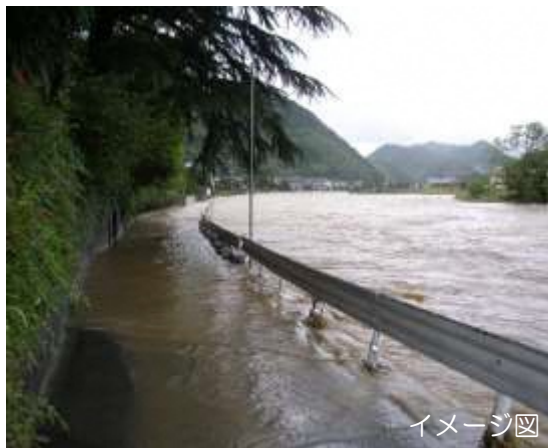
【護岸工事②（整備前）】
