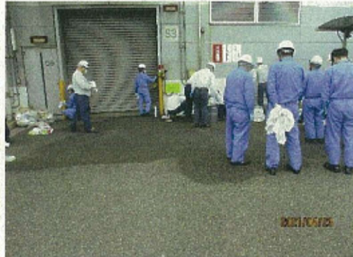
1期建屋東側 重油漏洩状況
