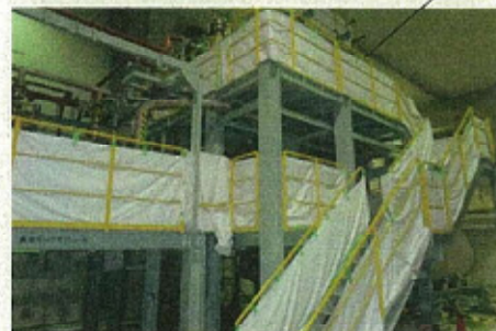
写真3 手摺箇所の落下養生対策
