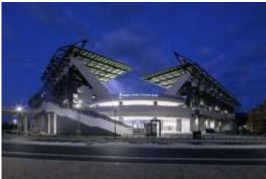
図 7-9 PFI 事業により整備した運動施設 (ミクニワールドスタジアム北九州)
