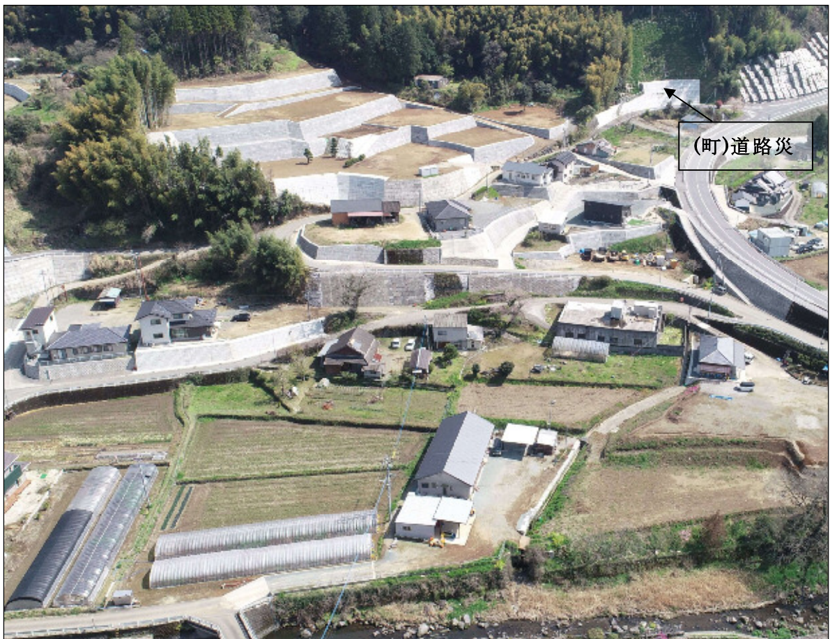
【杉堂1地区（東側）】しゅん工（R3.3）
