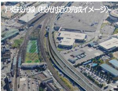
～主要幹線道路の整備～
