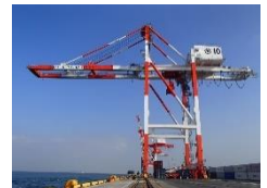
太刀浦コンテナクレーン
