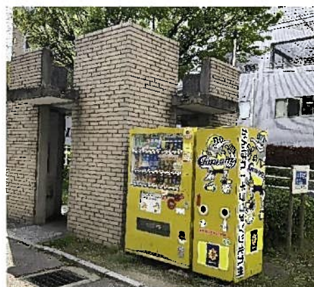
図７-６ 設置管理許可により 設置された自動販売機
