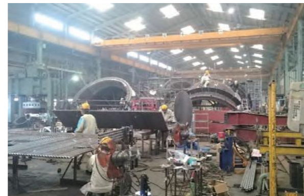
OG設備製作状況
