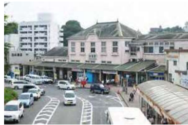
▲解体前の駅舎
