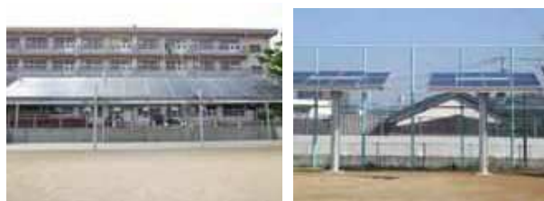
太陽光発電設備 (出力10kWの設置例) 太陽光発電設備 (出力3kWの設置例)
