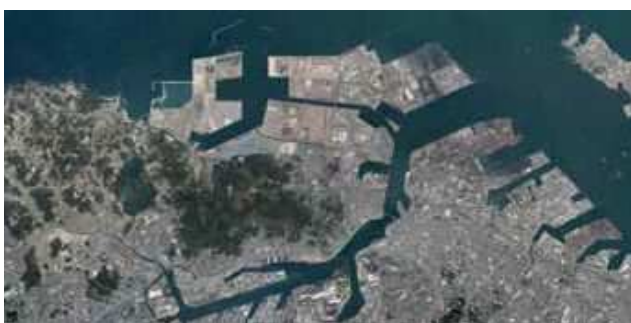
響灘地区全景 (平成29年2月)
