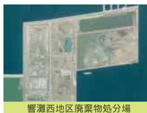
響灘西地区廃棄物処分場
