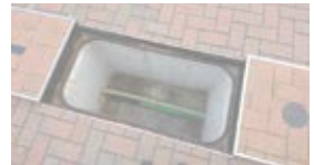
水素パイプライン
