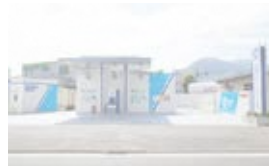
イワタニ水素ステーション 小倉 (岩谷産業(株):平成26年~)
