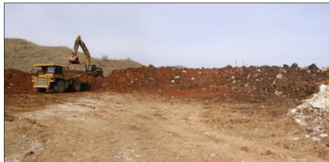
写真 26 重機の稼働状況と敷地境界の盛土（遮音壁）
