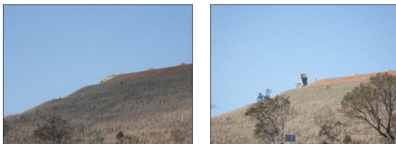
写真 29 調査地点から望む重機の稼働状況
