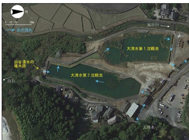
写真 32 白谷湧水の導水路の位置
