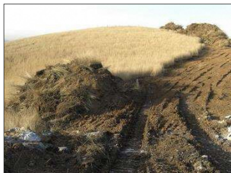
写真 91 表土活用工（左：表土、右：施工状況）
