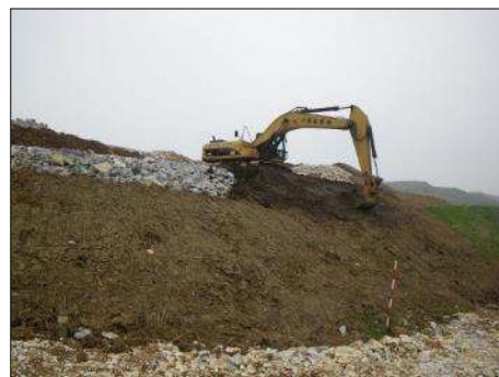
写真 91 表土活用工（左：表土、右：施工状況）
