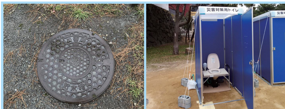
図 6-58 災害時に活用できる施設整備 (マンホールトイレ)
