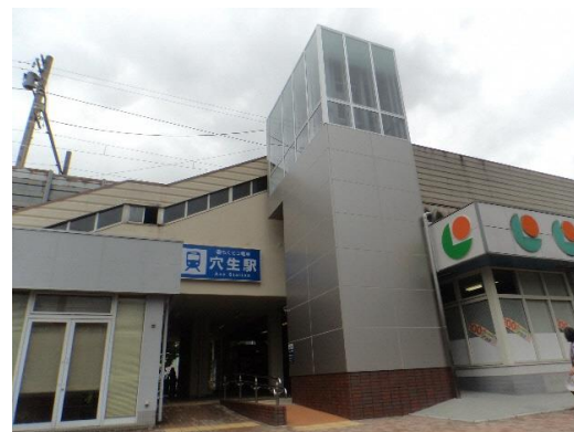
穴生駅(H28 完成)
