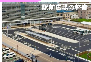
駅前広場の整備 八幡駅(R1完成)
