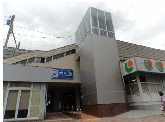
穴生駅(H28 完成)
