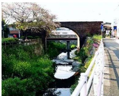
槻田川に架かる赤煉瓦造りのアーチ橋は、明治24年(1891)4月に開通した九州鉄道大蔵線の橋梁として構築されたものです。
