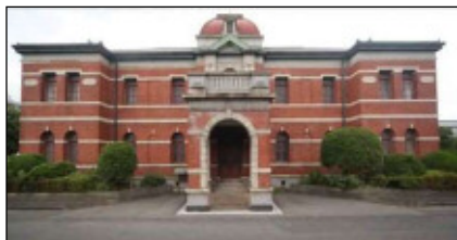
官営八幡製鐵所 旧本事務所
