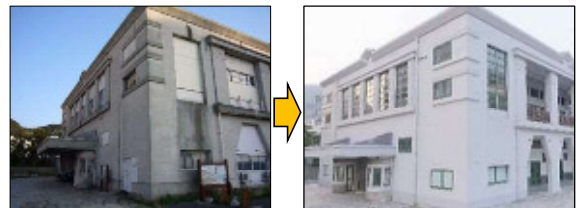
図 5-34 港湾施設を利用転換した事例
