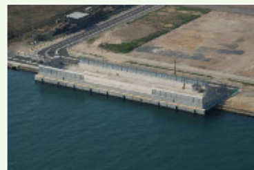
響灘リサイクルポート岸壁
