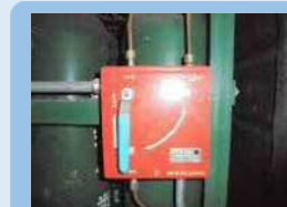
閉止弁（操作管）
