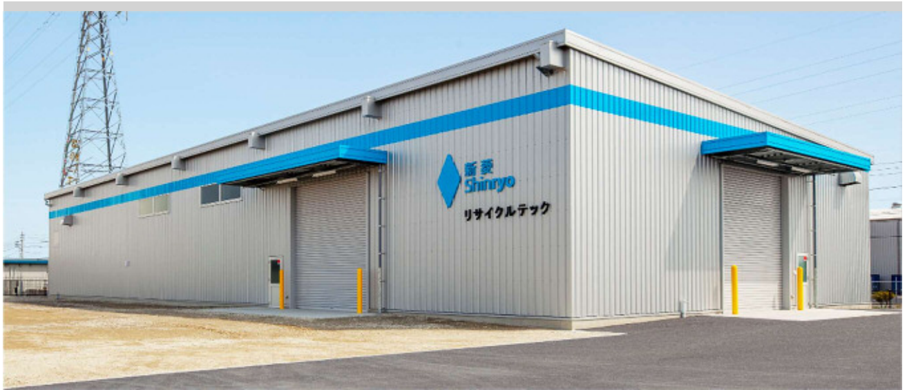
図1. 太陽光パネルリサイクル工場
