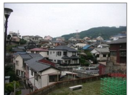
図 斜面市街地内の状況
