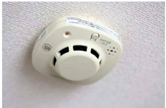
119番自動火災通報システム(感知器)
