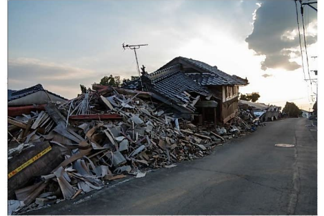
熊本地震（平成28年）
