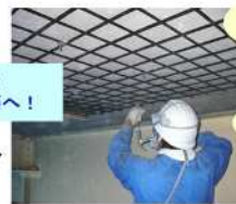
FRP格子筋の施工
