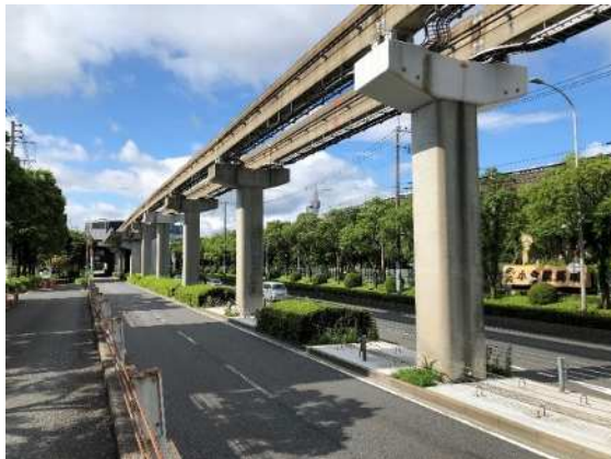
モノレールを支えるインフラ構造物(左側:軌道桁と支柱, 右側:停留場)
