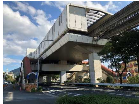
モノレールを支えるインフラ構造物(左側:軌道桁と支柱, 右側:停留場)
