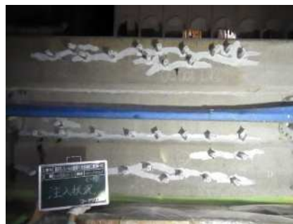
軌道桁(PC)のひび割れ補修
