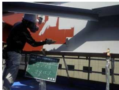
軌道桁(鋼)の再塗装
