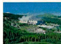
八丁原地熱発電所 提供：九州電力(株)
