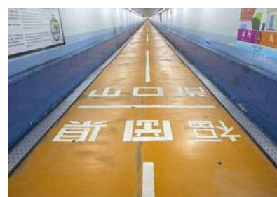
関門トンネル人道
