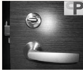
●C P対応の扉、枠、錠の設置 ●玄関灯、外灯の設置
